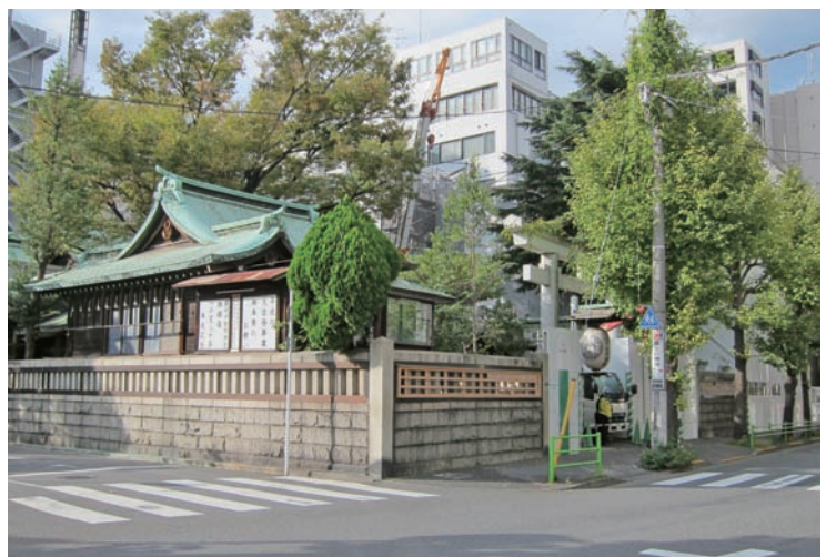
鉄砲洲稲荷神社（改修工事中）
